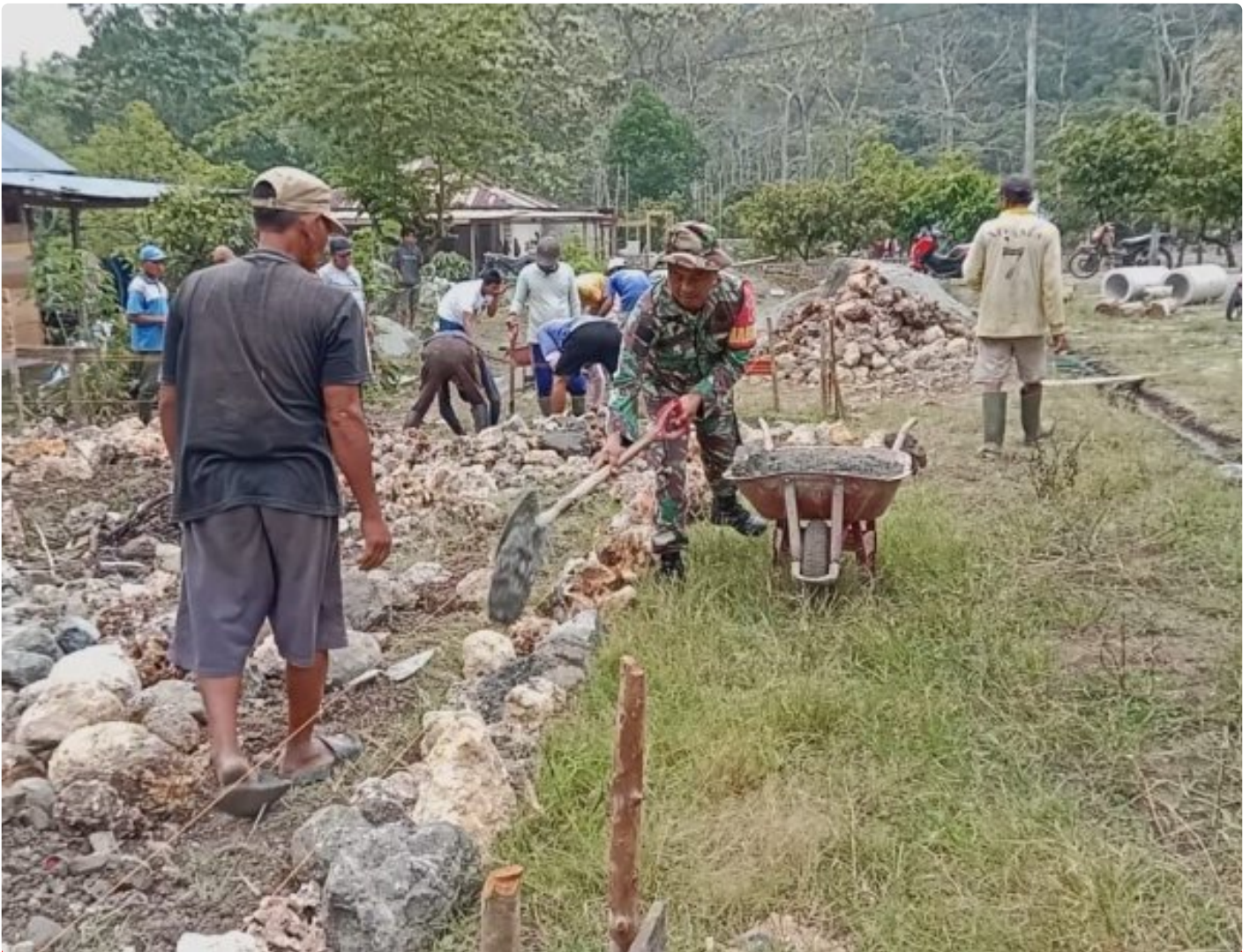
Gotong royong bangun pondasi rumah warga
