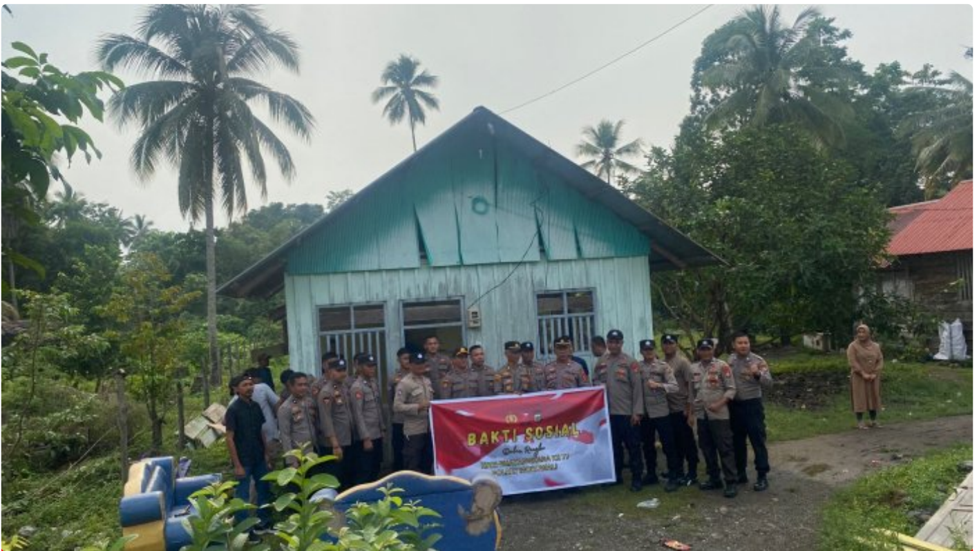
Tampak Memprihatinkan kondisi rumah warga Desa Bente yang dibedah Polres Morowali
